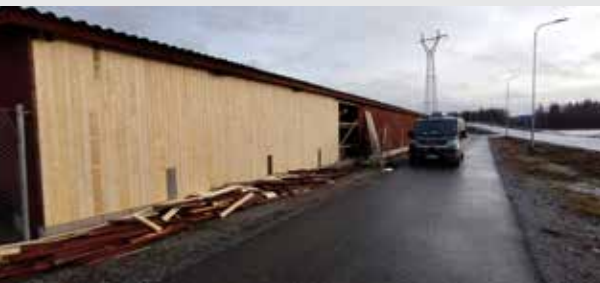
Båtskjulens brädfodring byts ut och ger ökad livslängd för skjulen.
